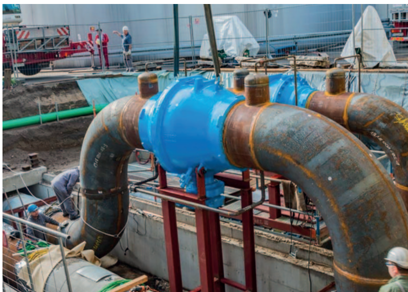
Robinet Ballostar KHSVI DN 1000 installé tête en bas
