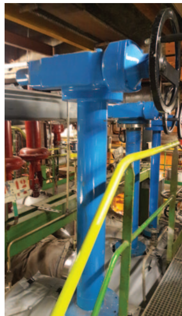
Robinet avec extension de manœuvre verticale
