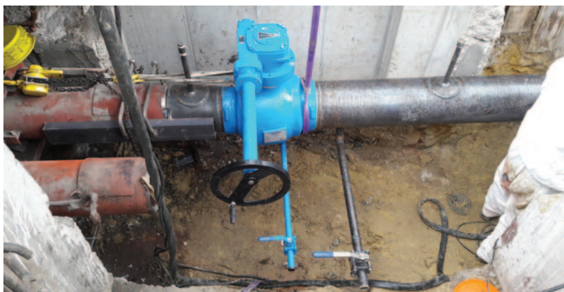
Robinet avec extension de manœuvre horizontale
