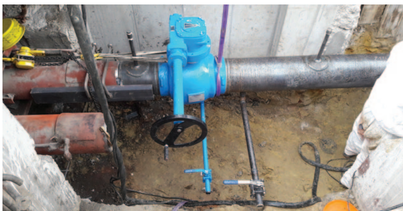
Robinet avec extension de manœuvre horizontale
