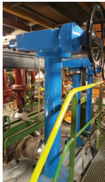
Robinet avec extension de manœuvre verticale
