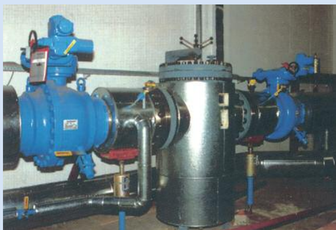
Robinet KLINGER Ballostar en sous-station
