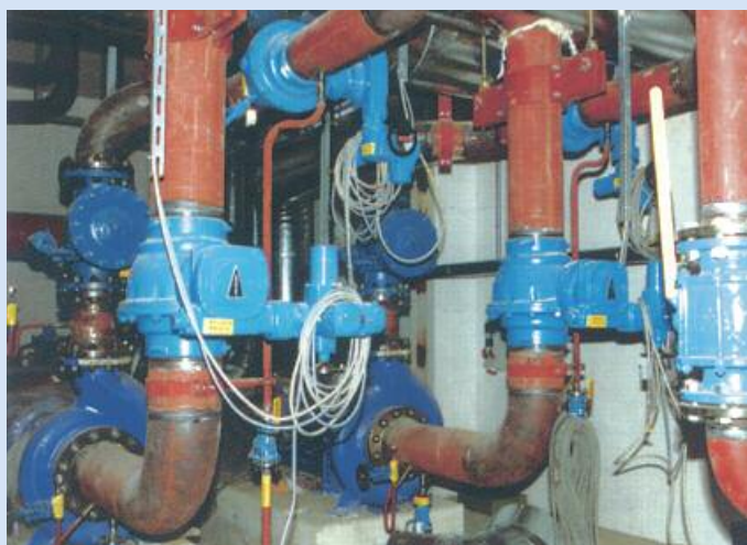
Robinet KLINGER Ballostar en départ de réseau
