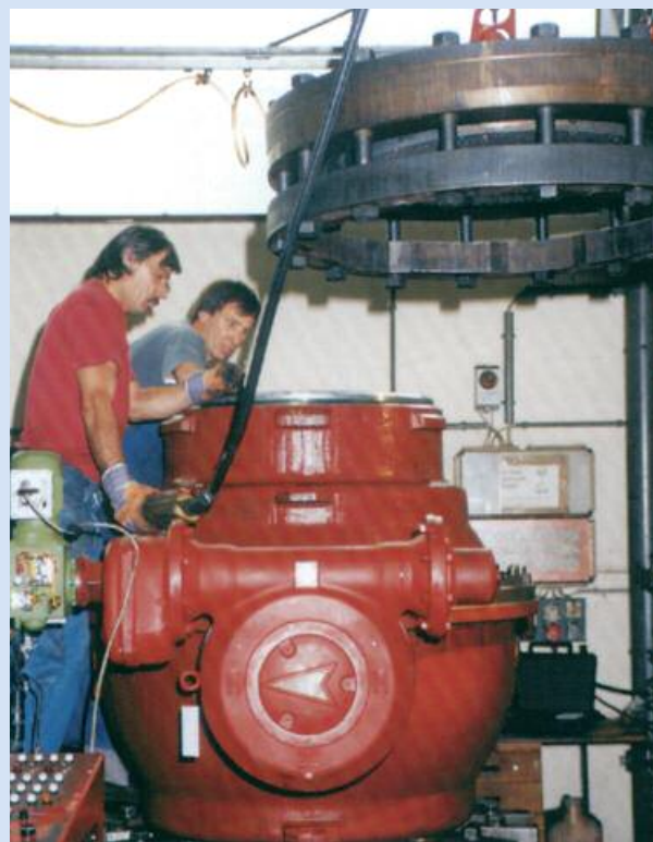
Test d'étanchéité suivant DIN 3230 (remplacé par la norme EN 12266-1) d'un robinet KHSVWI DN 700 installé Quai de la Bibliothèque de France (vapeur surchauffée 235 °C 20 bar)
