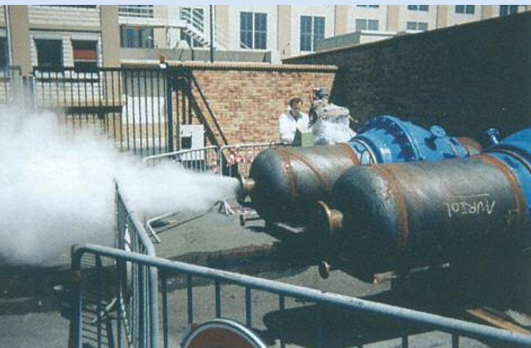
CPCU Paris : KLINGER Ballostar DN 700 à souder
